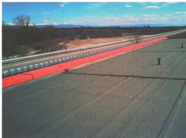
L'immagine termografica mette in evidenza un avanzato processo di distacco della membrana impermeabilizzante e la presenza di acqua sottostante.
