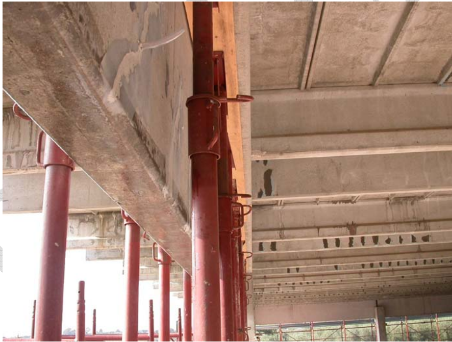
Figura 70. Rinforzo a flessione con compositi di una trave in c.a.
