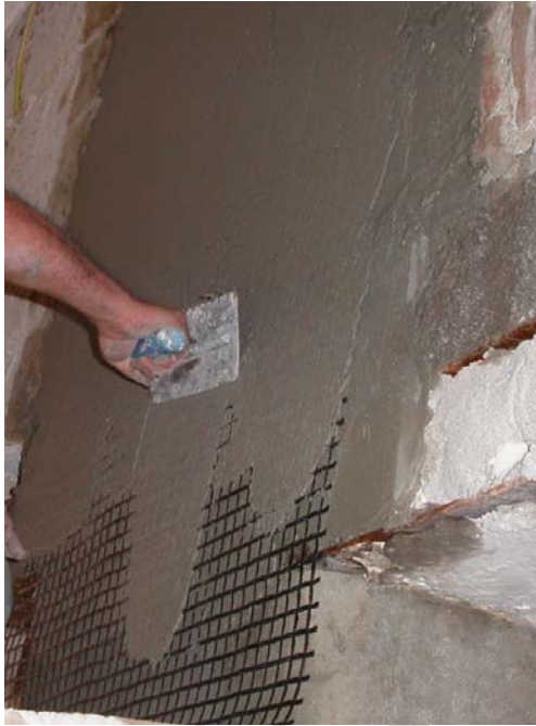
Lisciatura della superficie “fresca” con spatola piana.
