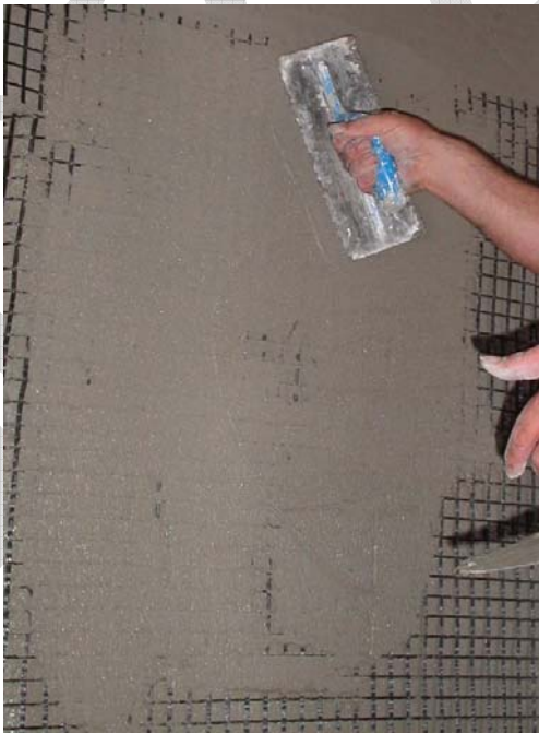
Lisciatura della superficie “fresca” con spatola piana.
